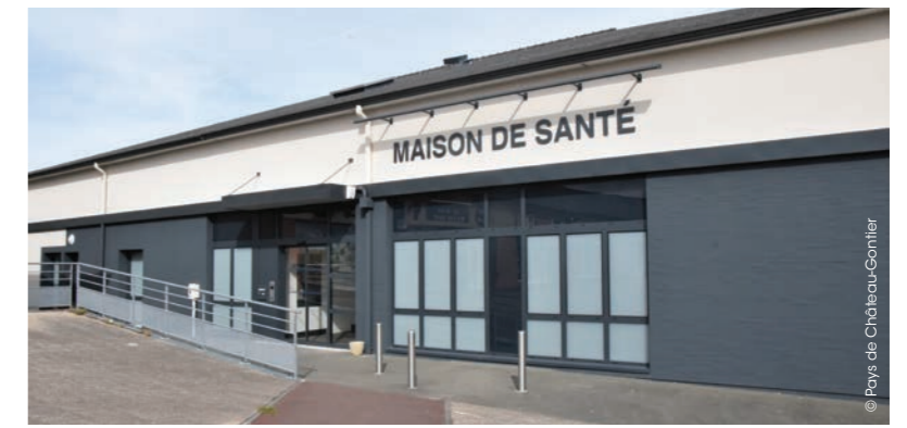
Maison de santé de Château-Gontier (53)
