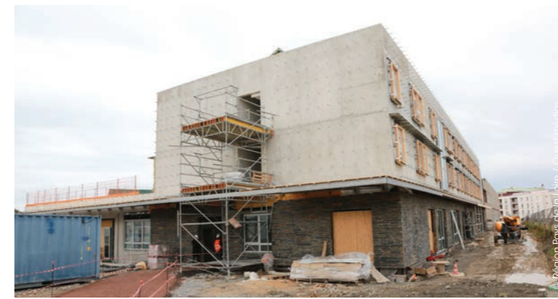
Chantier du lycée de Saint-Gilles Croix de Vie (85)
