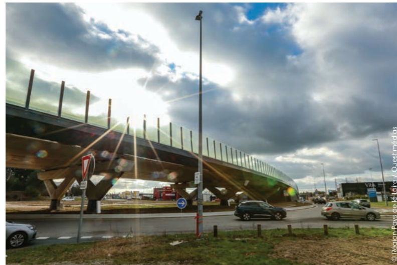
Viaduc sur le rond-point Palissy à La Roche-sur-Yon (85)
