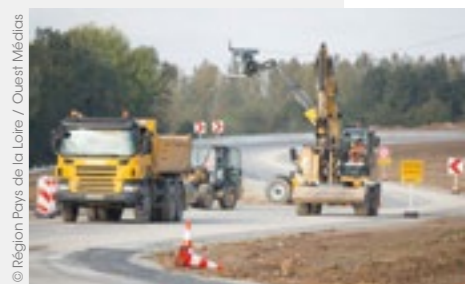
Travaux de contournement de Château-Gontier.
